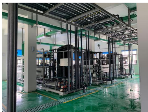
渗滤液处理站（地面防腐防渗处理）
