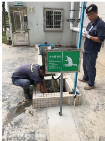
废水处理站出口
